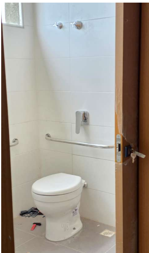
Figura 33 Instalação de vaso sanitário, assento, barras de apoio, acabamento para válvula de descarga e registro.
