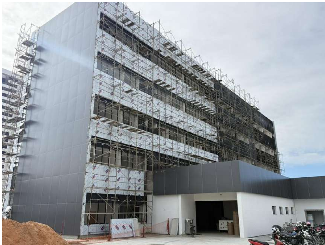
Figura 9 Instalação do ACM na fachada frontal e lateral norte da edificação.
