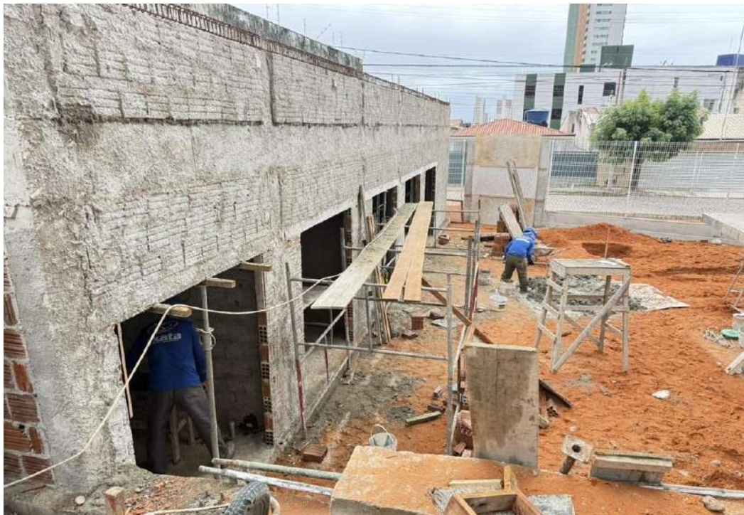
Figura 3. Execução da alvenaria da Casa do lixo
