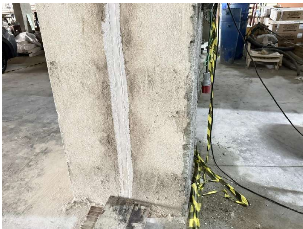
Figura 28 Instalação de junta de movimentação nos pilares do pavimento semienterrado 2.
