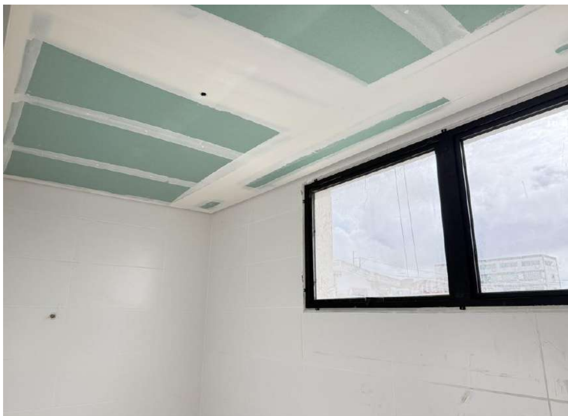
Figura 11 - Aplicação do forro drywall RU no banheiro acessível do pavimento térreo.
