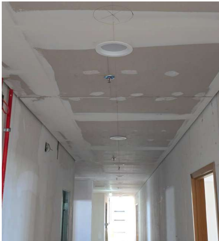
Figura 36 Instalação das luminárias em LED circulares.
