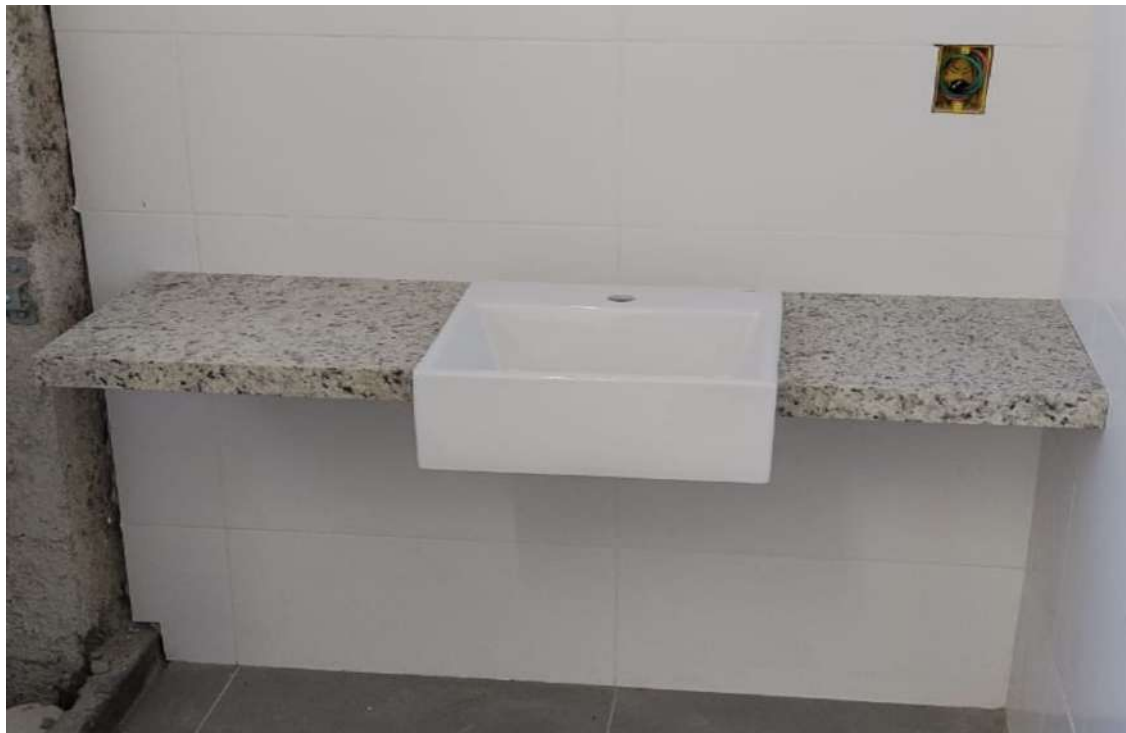
Figura 22 Instalação das bancadas para banheiros PCD.
