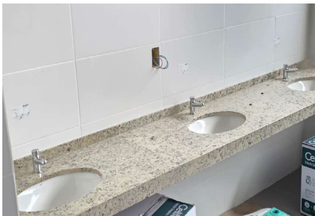
Figura 21 Instalação das torneiras de bancada.
