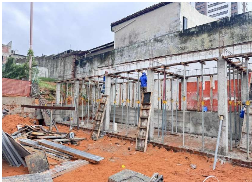
Figura 2. Execução da estrutura da Casa do lixo.
