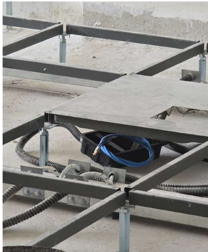
Figura 39 - Cabeamento Estruturado – Instalação de cabos UTP nas tomadas de piso elevado.
