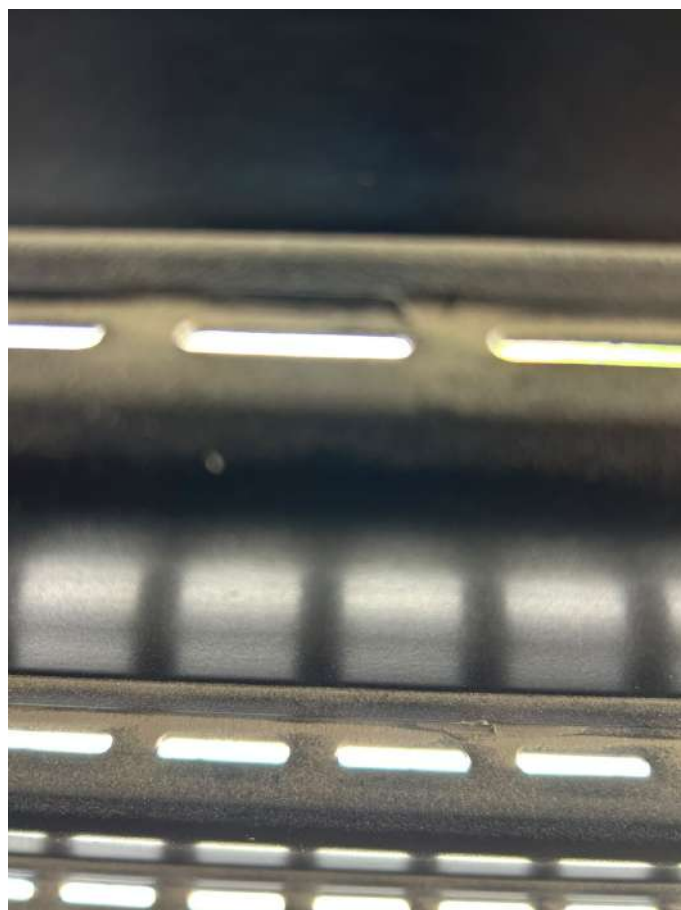
Figura 17 Janela da caixa de escada com inconformidades: altura diferente do especificado; área efetiva de ventilação insuficiente; distância da ventilação para o teto maior que 20 cm; e ausência de comprovação de que é de perfil metálico reforçado.
