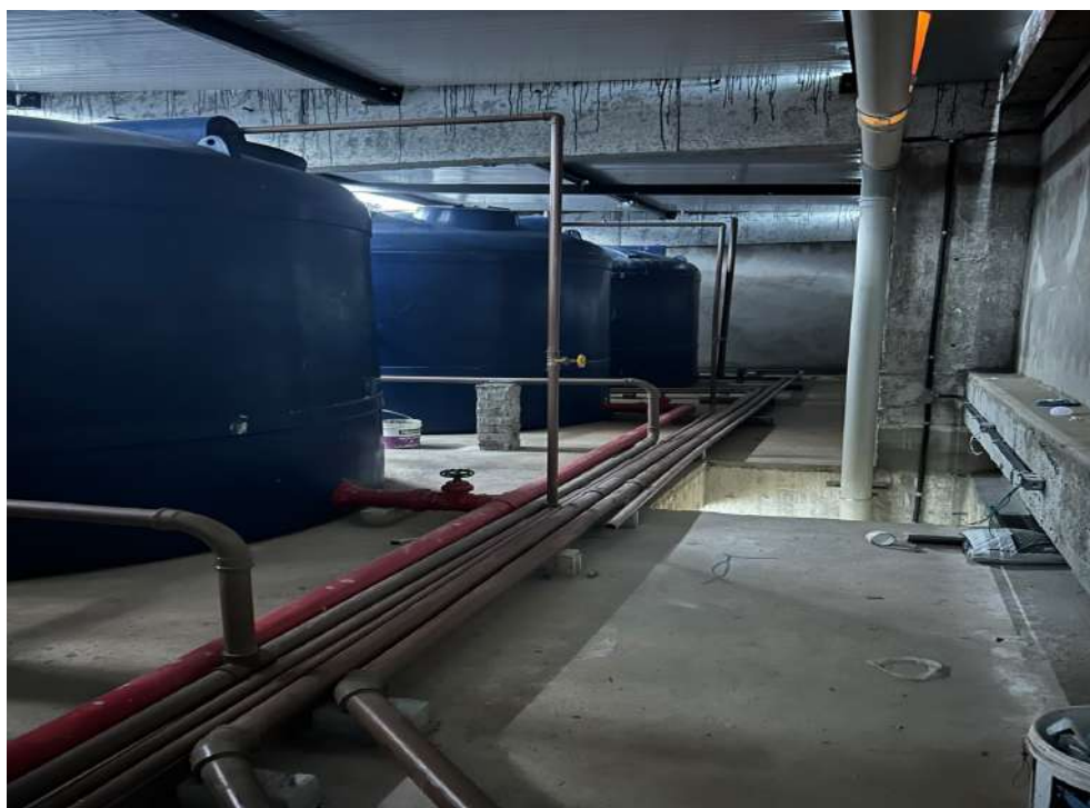
Figura 29 Tubulação de água fria.
