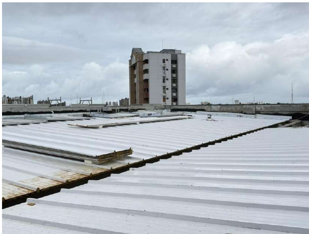
Figura 13 - Aplicação da telha trapezoidal de alumínio.
