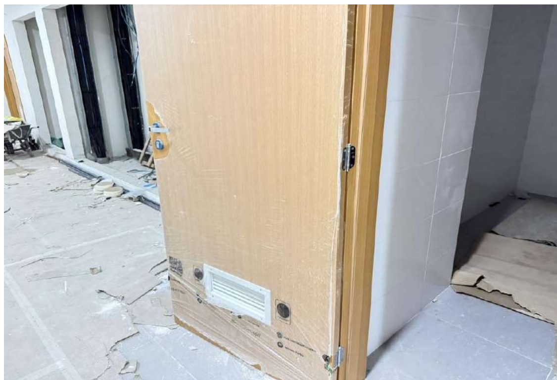
Figura 15 - Instalação das portas nos banheiros PCD.
