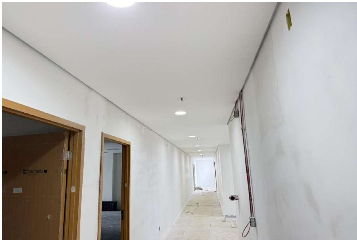
Figura 19 Emassamento de paredes e teto.
