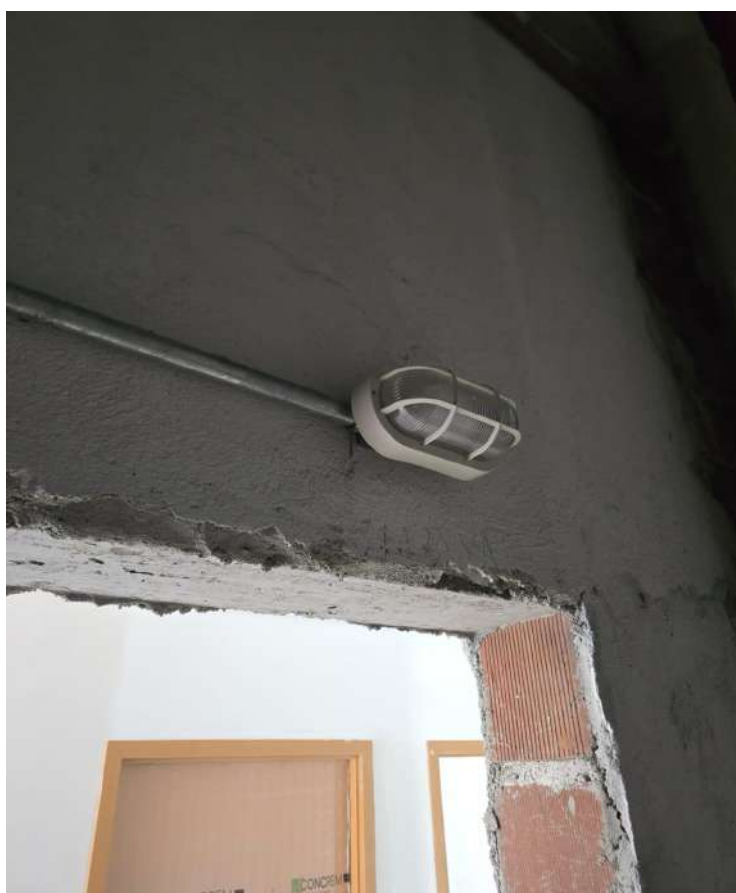
Figura 37 Instalação das luminárias tipo arandela.
