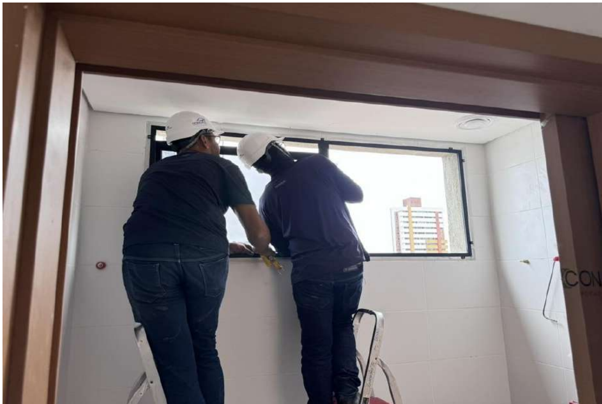
Figura 16 Instalação das janelas nos banheiros PCD.
