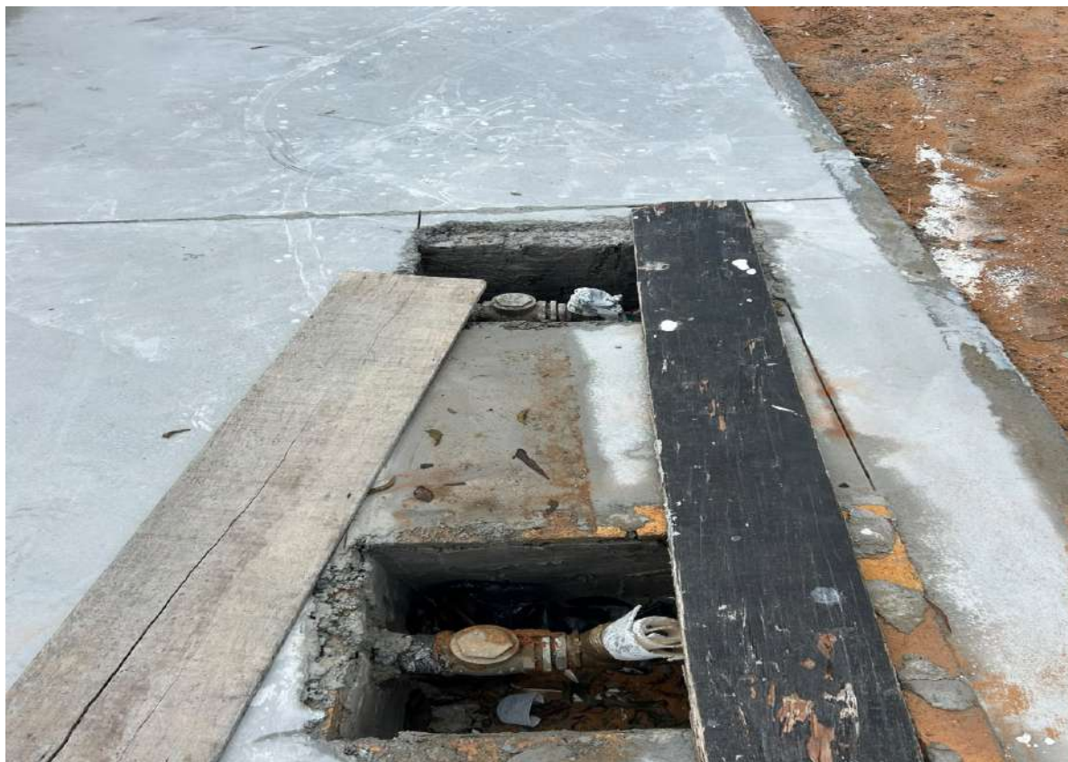
Figura 31 Instalação dos registros na calçada.
