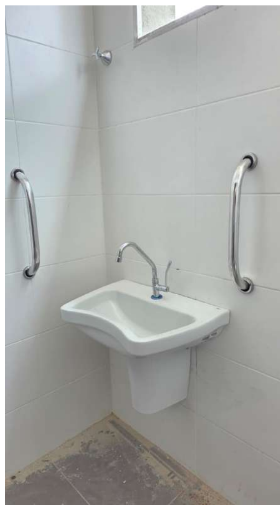
Figura 24 Instalação de pia, torneira e barras de apoio em banheiro PCD.
