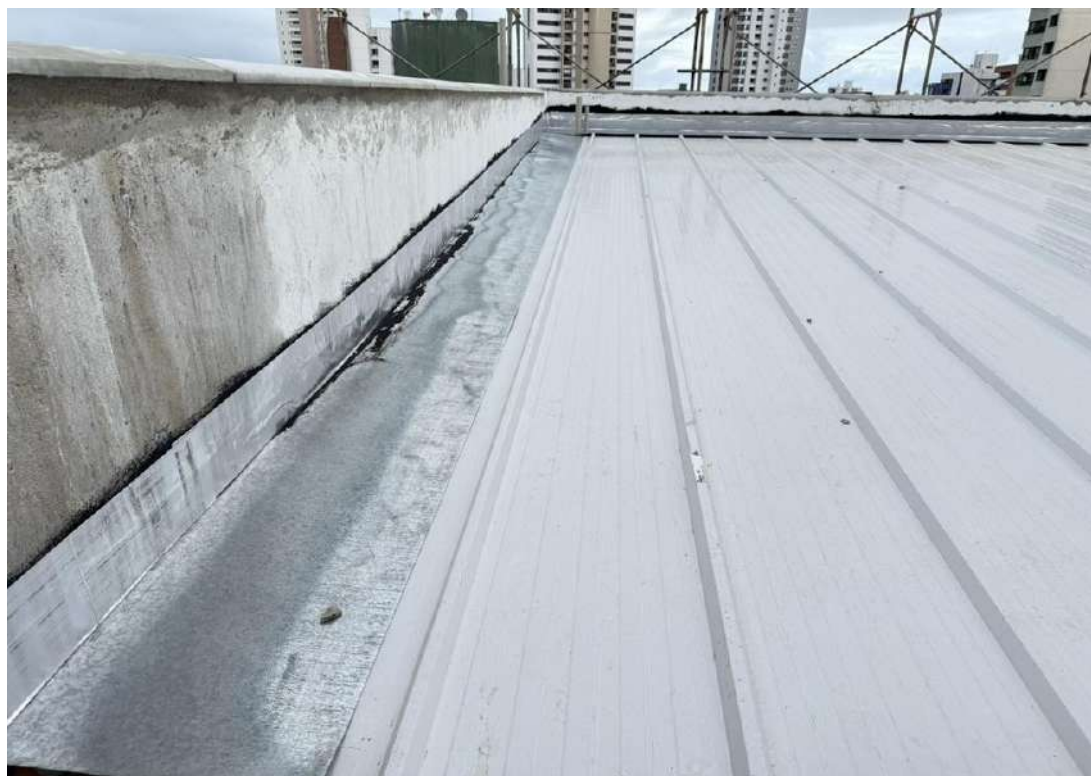
Figura 14 Instalação dos rufos na cobertura da edificação.
