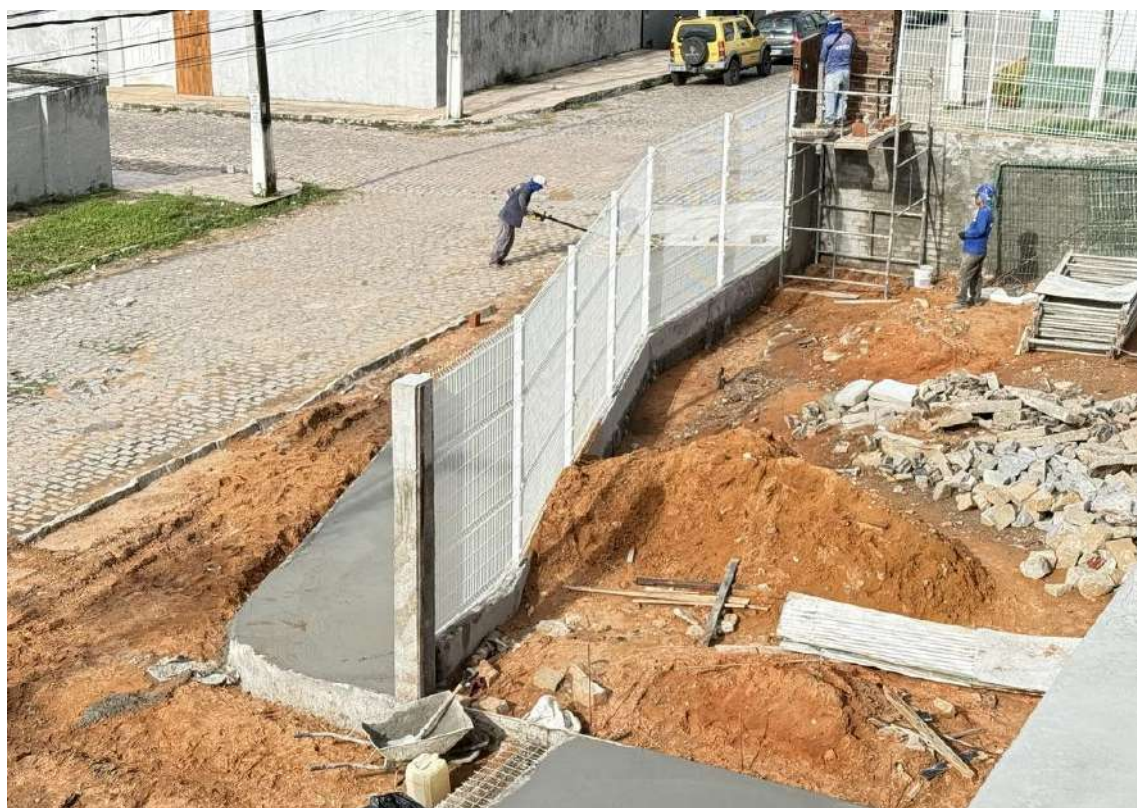
Figura 26 Instalação das muretas e gradil na lateral norte da edificação e acabamento do piso da calçada.
