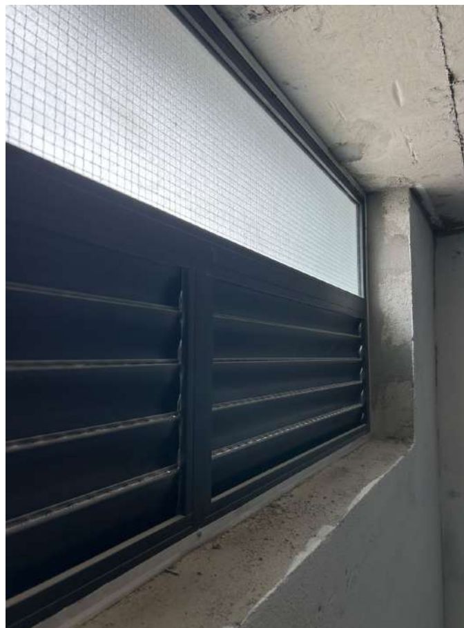
Figura 17 Janela da caixa de escada com inconformidades: altura diferente do especificado; área efetiva de ventilação insuficiente; distância da ventilação para o teto maior que 20 cm; e ausência de comprovação de que é de perfil metálico reforçado.
