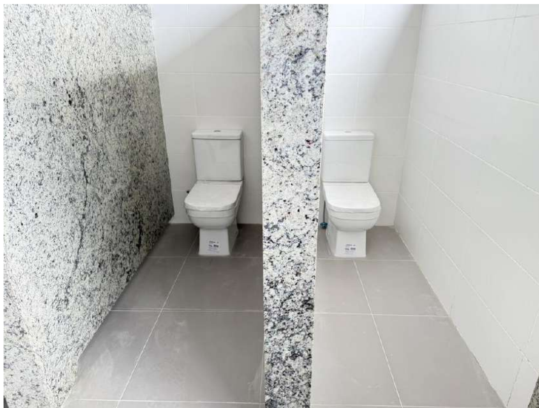
Figura 20 Instalação dos vasos e assentos sanitários nos banheiros coletivos.
