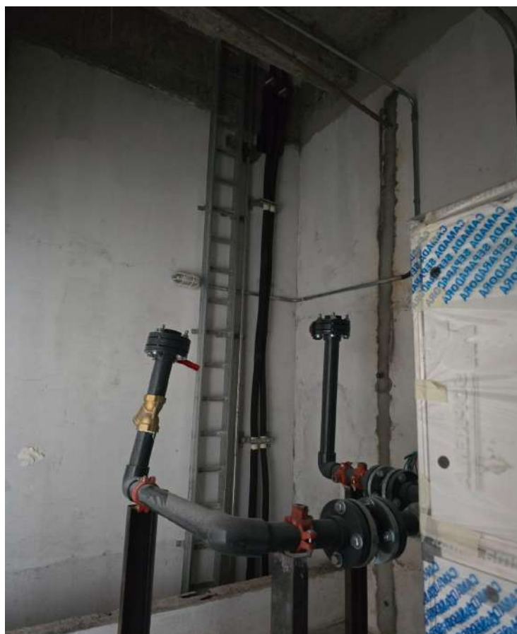
Figura 40 - Ligações típicas Fancoil.
