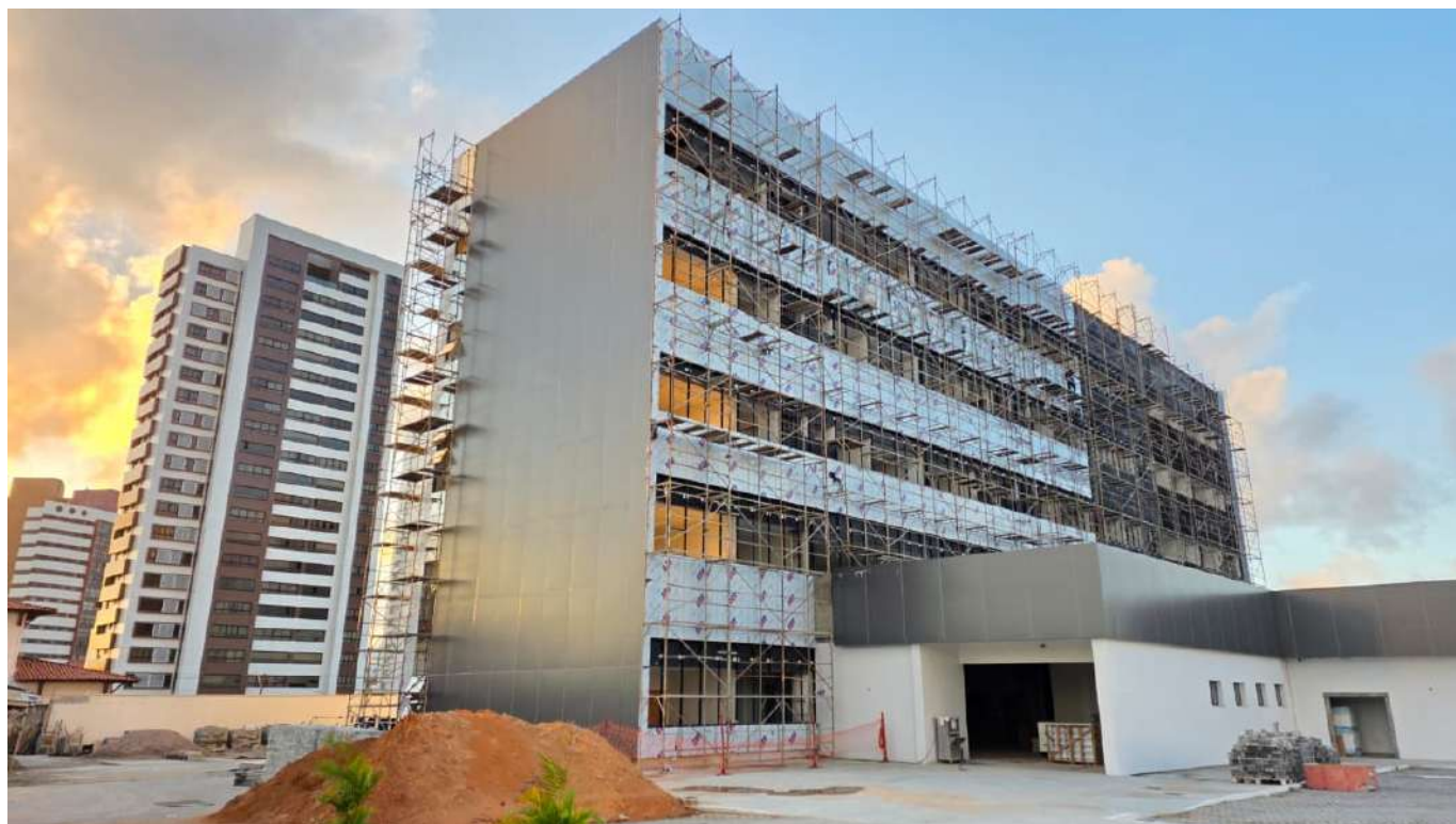
Figura 1. Visão geral da obra.
